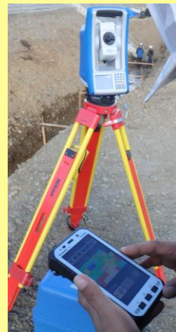
建設システム SITECH3Dにて 1 施工単に 3D設計データを分割
